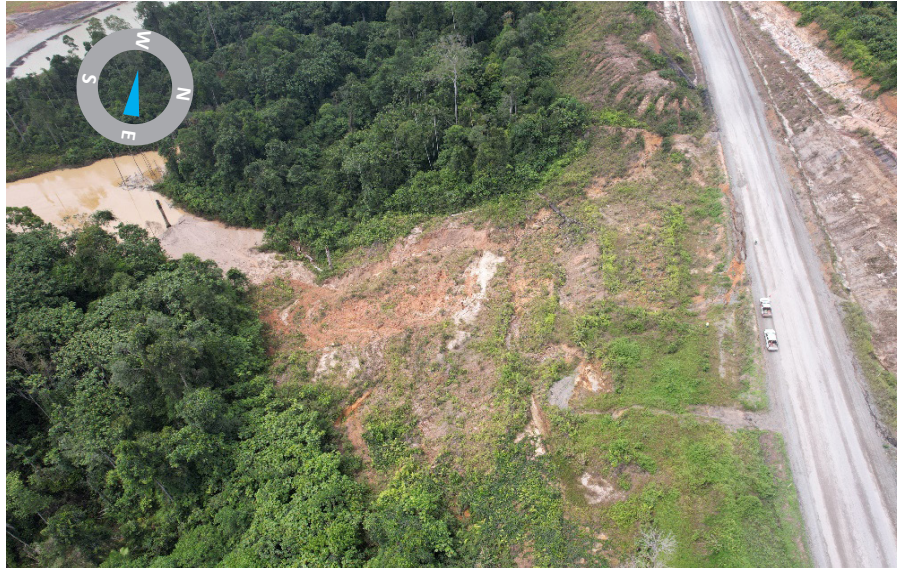
Gambar 1.3 Area Longsoran Sisi Kosongan Jalan Hauling KM 78.500 PT X
