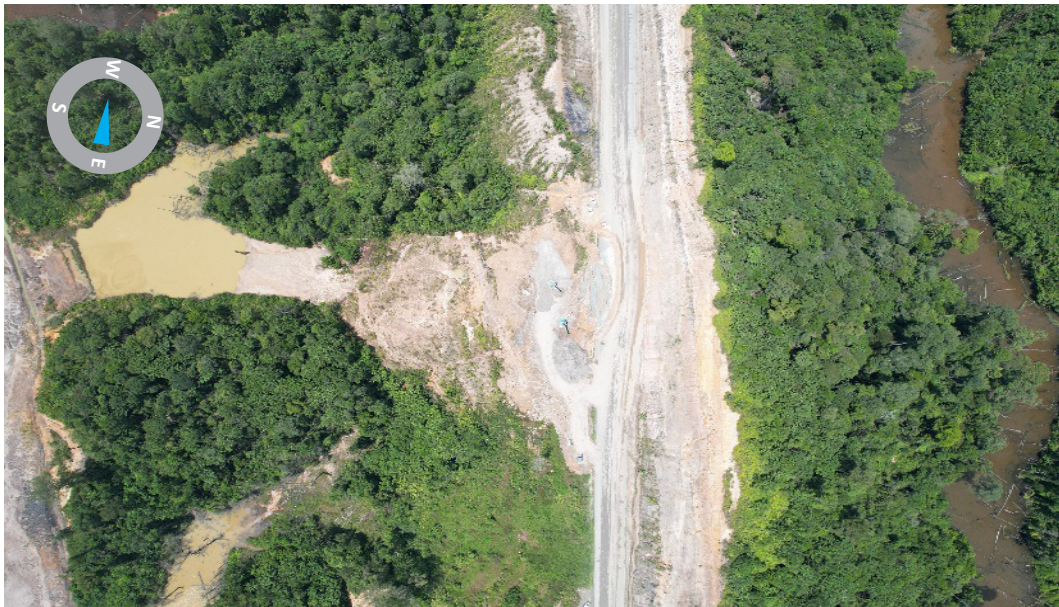
Gambar 2.3 Lokasi Longsoran Tampak Atas
