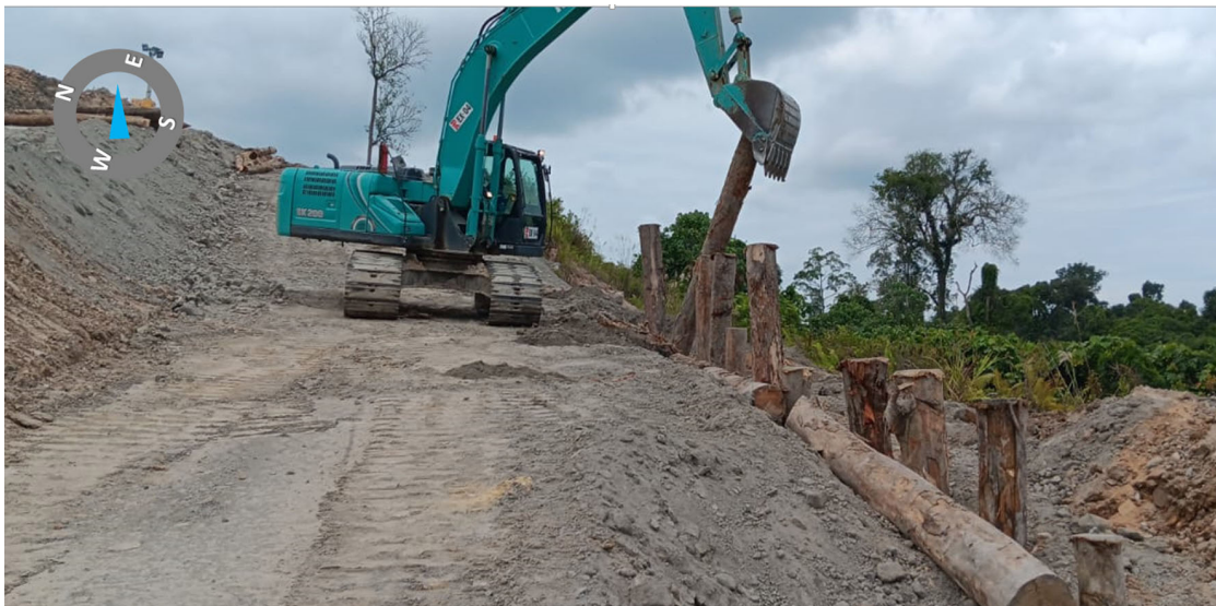
Gambar 3.7 Pemancangan Log Kayu pada Toe of Slope
