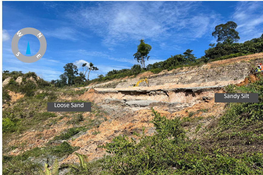
Gambar 1.2 Longsoran Busur pada Jalan Hauling KM 78.500 PT X
