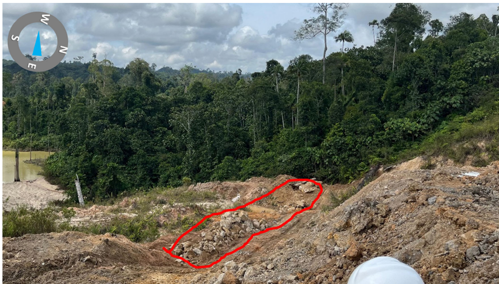
Gambar 3.6 Boulder pada Dasar Timbunan
