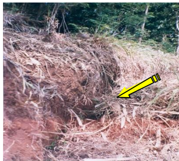
c. Tanah kebun patah akibat gempa di Cisalada, Desa W. Saluyu (Salman dkk, 2005)
